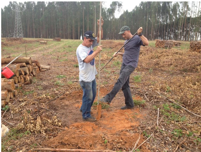
Foto 6 – Execução da Sondagem ST-2 dentro da área correspondente ao plantio de eucalipto.
